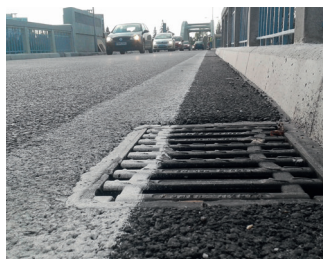
Obr. 2 Osadenie odvodňovača pri obrubníku
