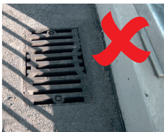
Obr. 1 Osadenie odvodňovača s osou 250 mm od obrubníka
